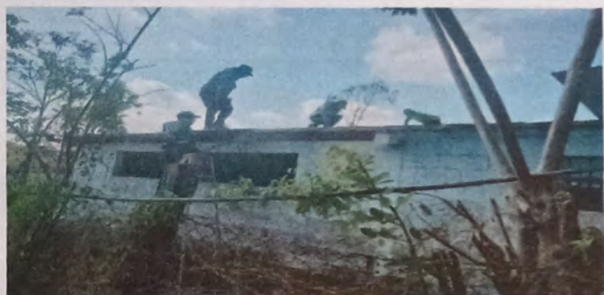
Foto 3: Desinstalacion de de techo modulo 3.
