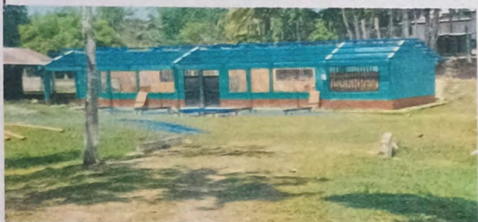
Foto 1: Desinstalacion del Modulo 1. en cuanto a techo.
