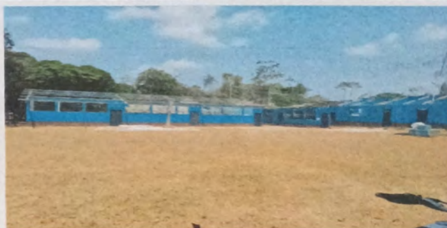
Foto 2: Desinstalacion de de techo modulo 2.
